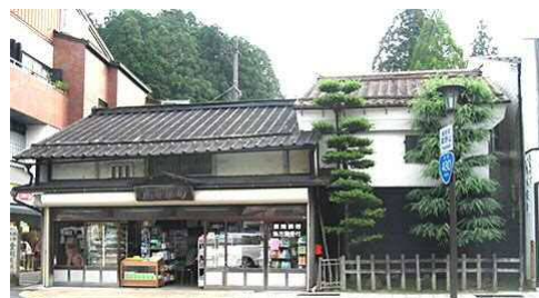
虎屋薬局 (H21.3.16 指定景観重要建造物)
