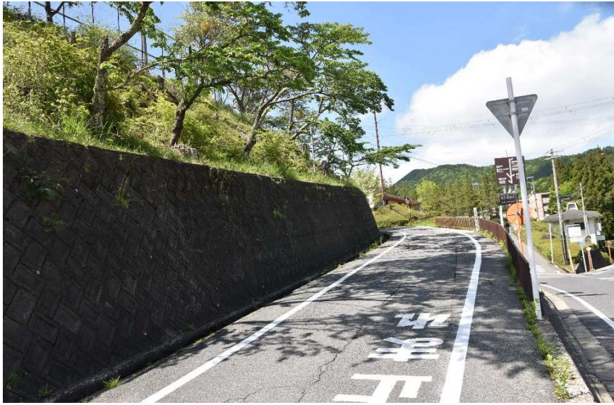
① 町道 中学校線 入口
