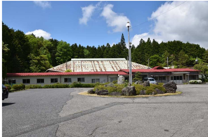
⑧ 手前 給食センター 奥 スケートリンク上屋
