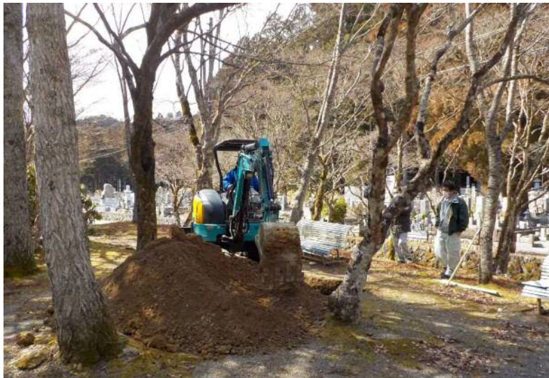
埋蔵文化財の確認調査 掘削状況
