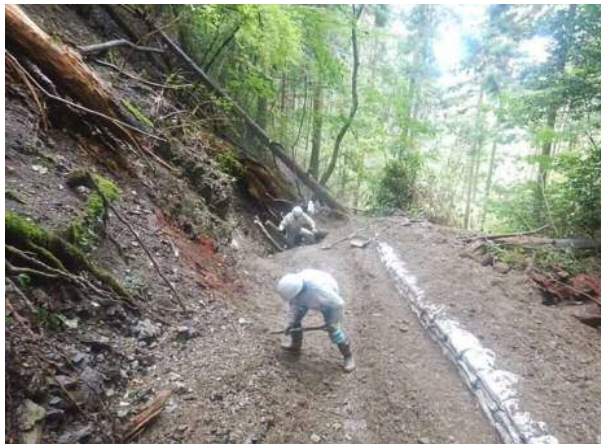
処理作業状況
