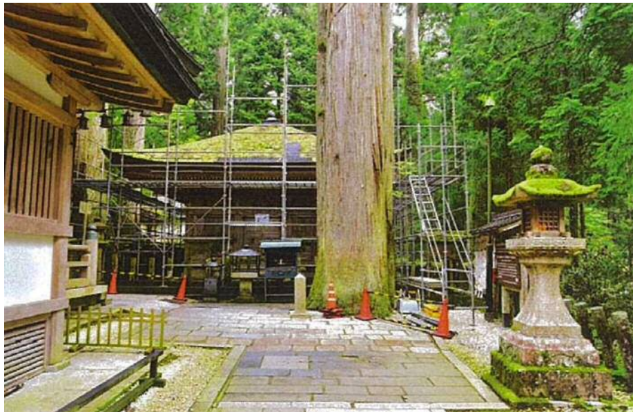
重要文化財建造物 金剛峯寺奥院経蔵の修理状況
