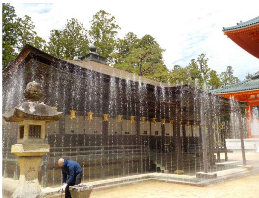
防火設備の点検状況
