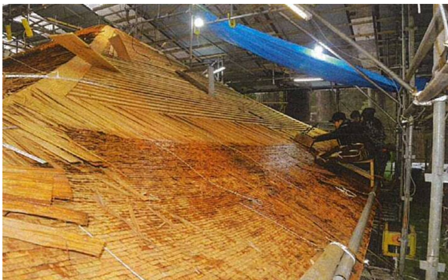
金剛峯寺奥院経蔵修理状況(檜皮葺き替え)
